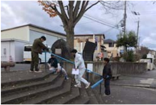
親水公園排水口と手摺設置
